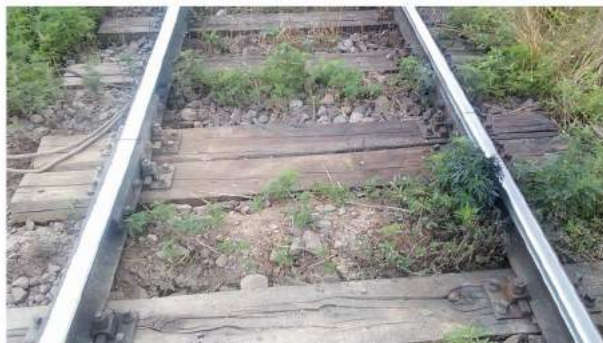
Fig. 8 – fotografia cu zona colmatată
