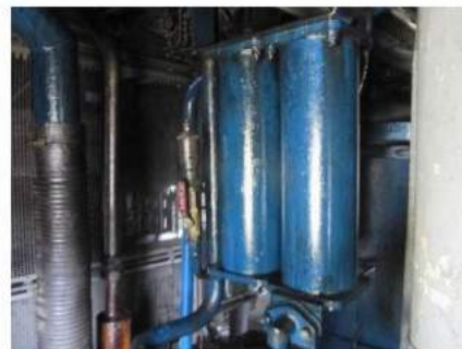
Foto nr.5 - rezervoarele de silicagel ale instalației pneumatice
