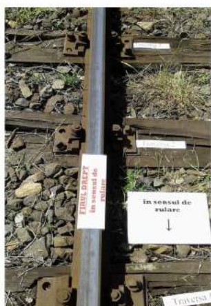
Foto nr.6 - Traversa 1, 2 și 3 din cale
