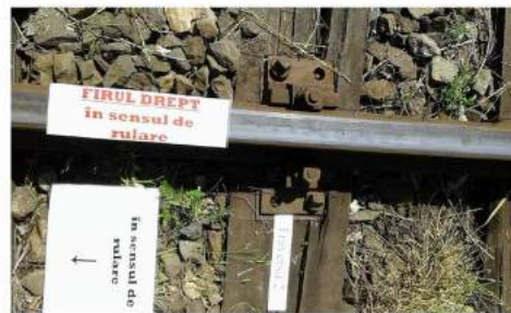
Foto nr.4 - Traversa 2 din cale
