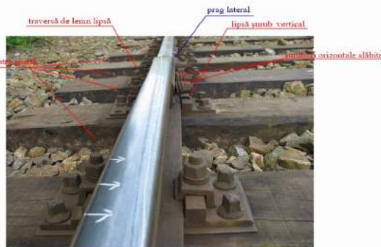
Figura 8 – detaliu cu joantă realizată neinstrucțional
