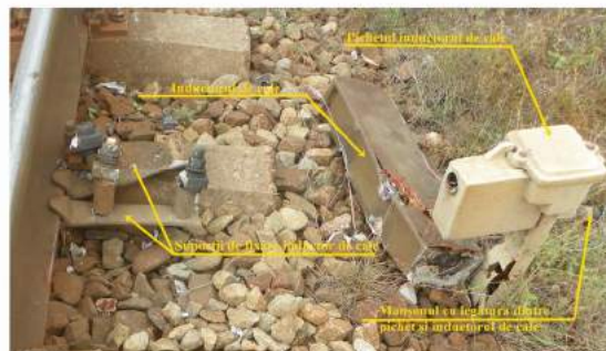
Fig. 3 Inductorul de cale al semnalului luminos de ieșire X II smuls și deteriorat
