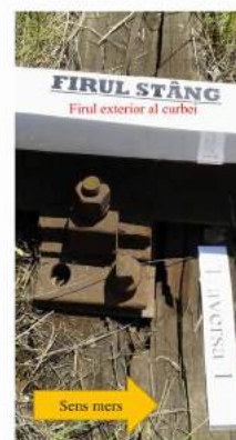
Foto nr.3 - Traversa 1 din cale
