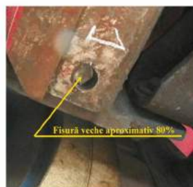
Fig.6 Parte filetată a șurubului rămas în locașul suportului suspensiei
