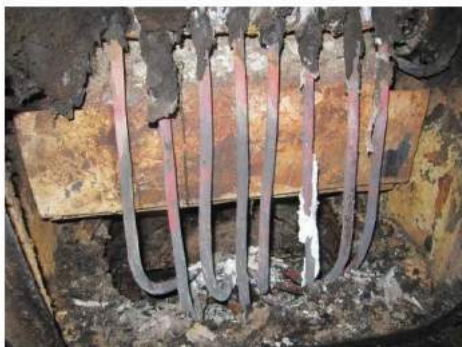
Foto nr.1 – Cablurile de forță la MT nr.4 cu izolația arsă
