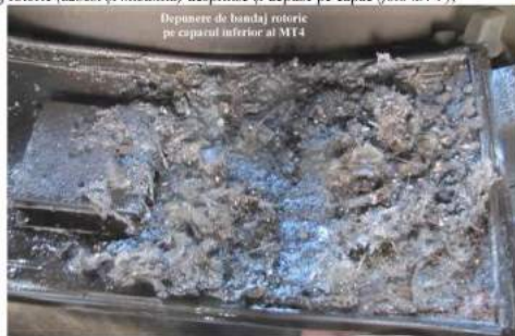
Foto nr.4 – depuneri pe capacul motorului de tracțiune nr.4
