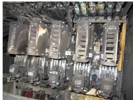
Foto nr.2 – Contactorii electropneumatici și cablajul aferent - bloc S4
