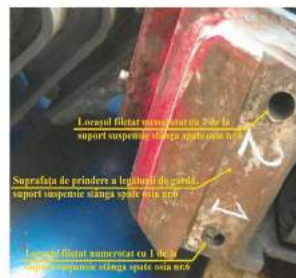
Fig.4 Capătul suportului suspensiei, osia nr.6, stânga, spate.
